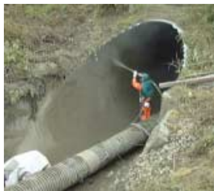
Betongsprutning av vägtrumma i Xxxxxx.
