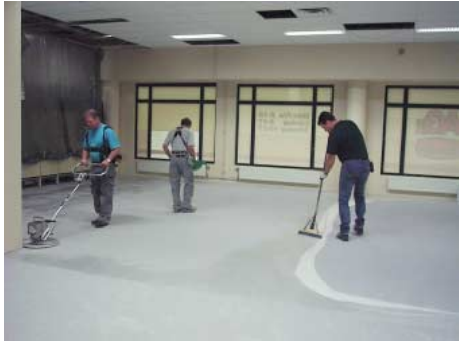
Golvebelägningsarbete på AG's Favör i Landskrona.
