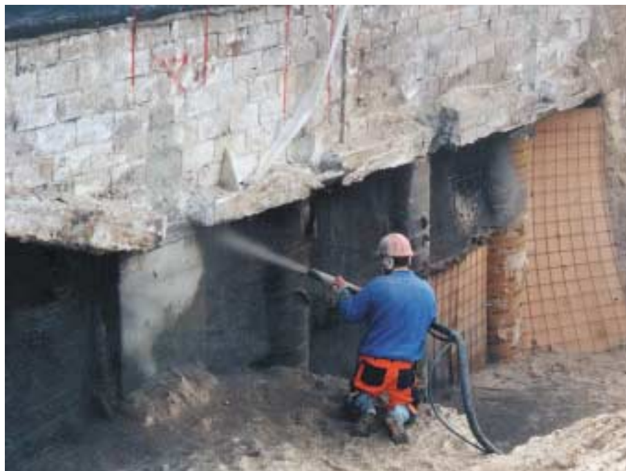
Betongsprutning av bro i Xxxxxxxx.
