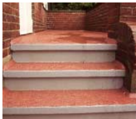
Acrylbeläggning på altan i Helsingborg.
