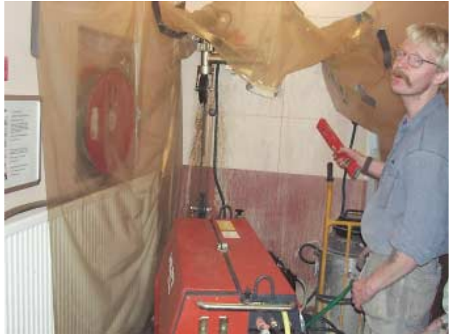
Wiresågning av dörr i 75 cm betongvägg på Telia i Helsingborg.
