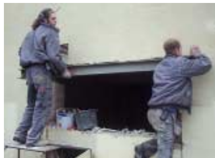
Upplagg av balk vid Hemlock i Helsingborg.
