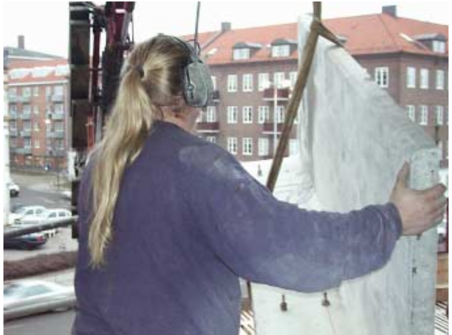
Nedlyft av demonterade läktarelement på Olympia i Helsingborg.
